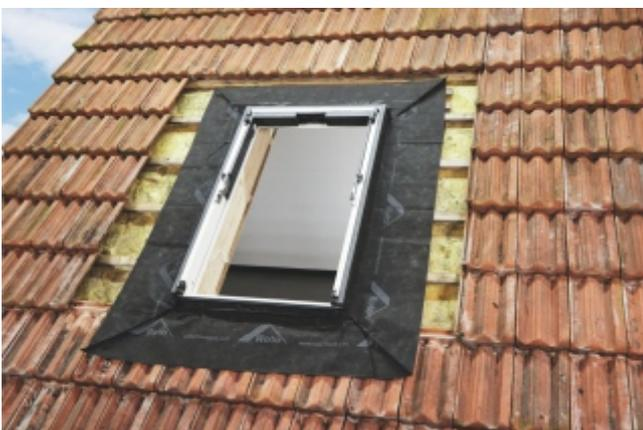
Гидроизоляционный фартук - гидро- и ветроизоляция ASA
